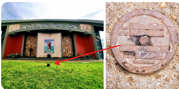
Figuras 49 e 50: Estação Geodésica - Paróquia São Cristóvão.
