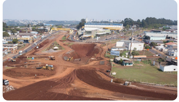
Figura 114: Obras no Trevo Cataratas. Fonte: Ecocataratas (2021).
