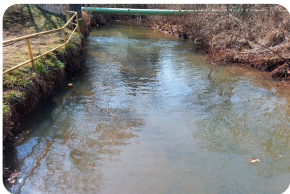
Figura 210: Rio Peroba. Fonte: Companhia de Saneamento do Paraná (Sanepar, 2021).
